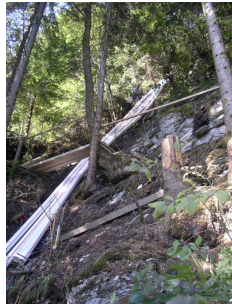
Provisorisch verlegte Rohre vor dem Einbringen des Hüllbetons
