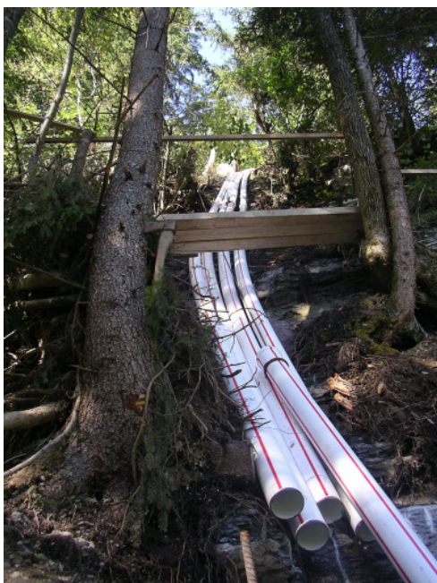
Rohre vor dem Zudecken mit Erdreich
