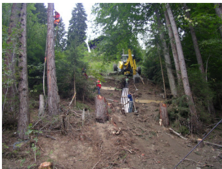
Schreitbagger beim Zwirgi unterhalb Wengen
