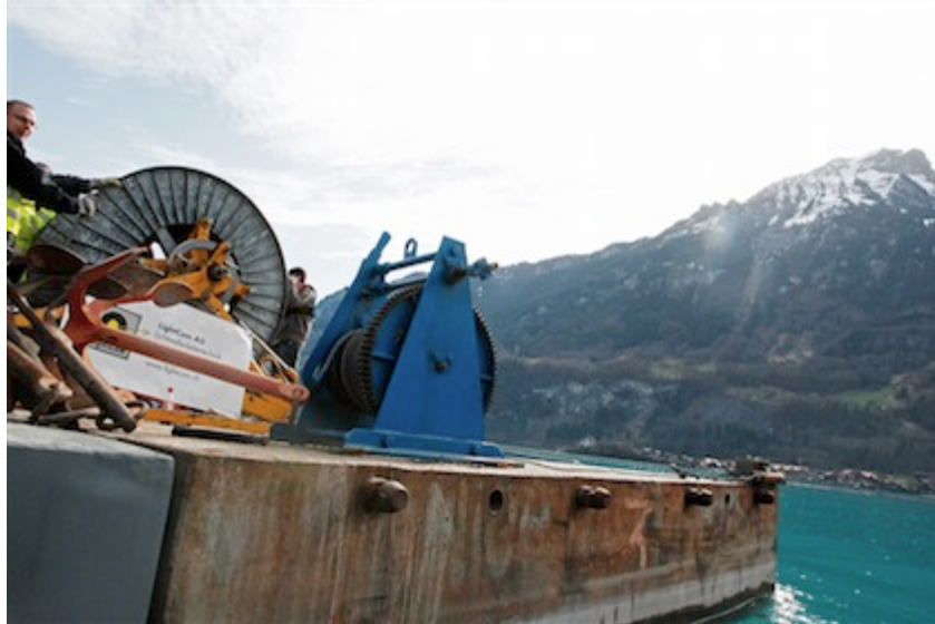
Die Verlegung erfolgte per Floss: Von der Spule wird das 2,8 Kilometer Lange Kabel langsam auf den Grund des Sees positioniert.
