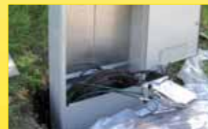
Kollision von Fahrzeug mit Verteilkabine
