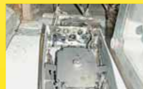
Brände durch Blitz Kurzschlüsse von nebenliegendem Hochspannungskabel
